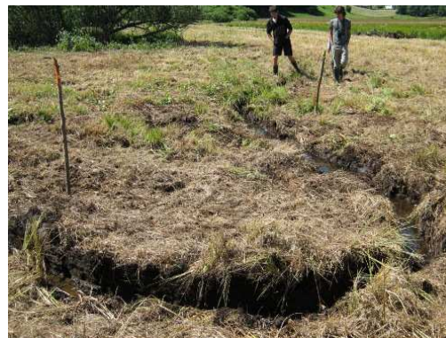
Figure 6 et 7 : Traçage du lit guide en suivant le pique piquetage
