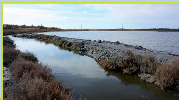
> Les boues de curage ont permis de consolider la digue d'origine
