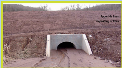
> Colmatage du fossé par des particules fines de chantier
