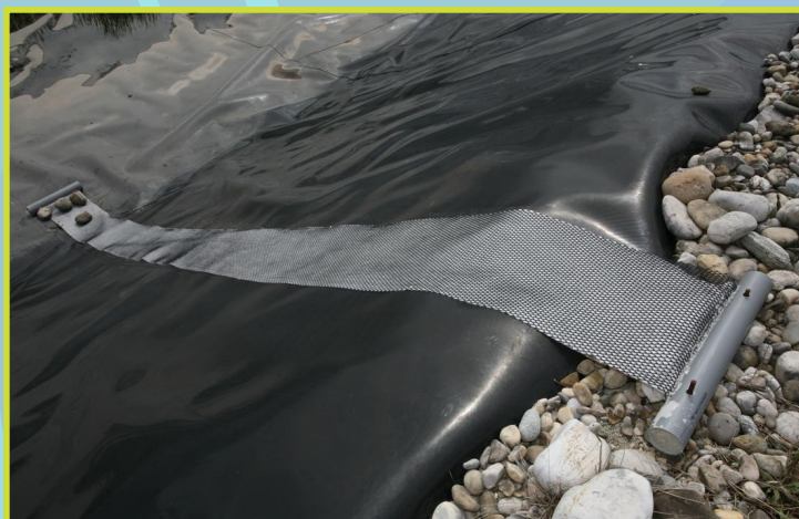
> Dispositif permettant à la faune de sortir des bassins (J.F. Noblet - CG 38)
