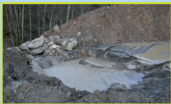
> Bassin de décantation sous dimensionné et exempt de dispositif de filtration (Sétra)
