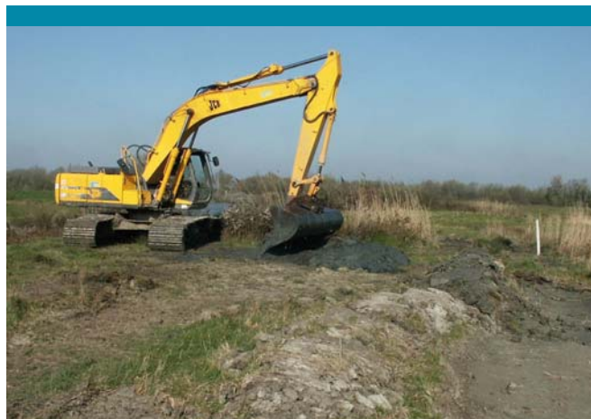
Zone humide remaniée et travaux de terrassement
