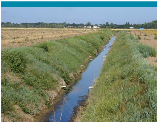
Fossé drainant traversant une zone humide
