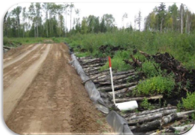
Rondins, géotextile et bande de roulement dans une tourbière canadienne
